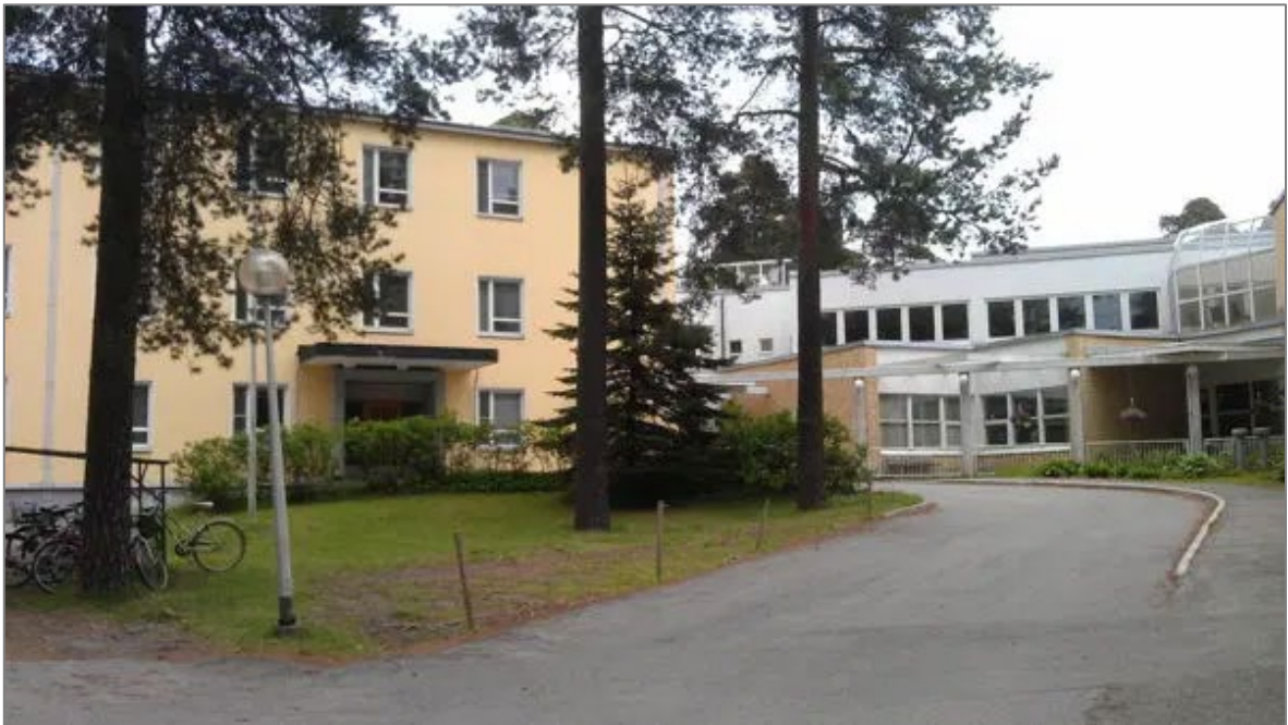
Kuva 5: Oikealla purettu 1980- luvulla valmistunut siipiosa.
